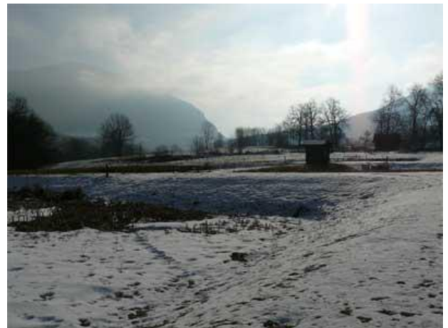
Figure 2 : Station d'épuration à filtres plantés de roseaux de Curienne (Savoie)
